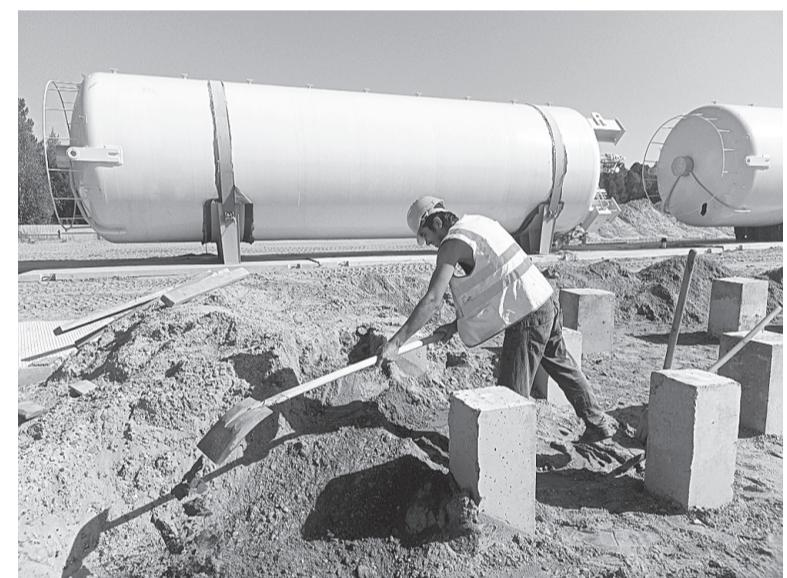
компанией «Газпрома» схема станции регазификации включает в себя несколько стационарных криогенных ёмкостей-хранилищ СПГ, узел заправки, систему атмосферных испарителей и электрический подогреватель, соединённые между собой трубопроводами и арматурой.
