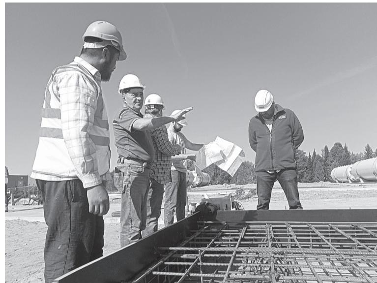
Томска, - объясняет прораб. - Вообще, сначала идёт бетонная подготовка, затем армирование плиты и лишь потом бетонирование. После окончания всех бетонных работ приедут электрики, монтажники и другие, которые приступят к установке оборудования. Работы много».
