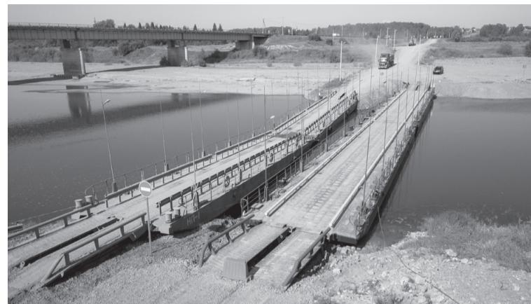
та 2018 года из-за потери несущей способности конструктивных элементов он работал в реверсивном режиме для автотранспорта с общей массой до 15 тонн.
