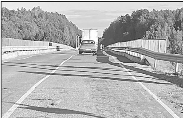
2018 года для движения большегрузных автомобилей был возведен понтонный мост, а режим ЧС был снят. Старый железобетонный мост сейчас работает в реверсивном режиме с ограничением скорости до 30 км/ч и общей массой транспорта до 15 тонн. Стоимость его ремонта сравнима со стоимостью строительства нового.
